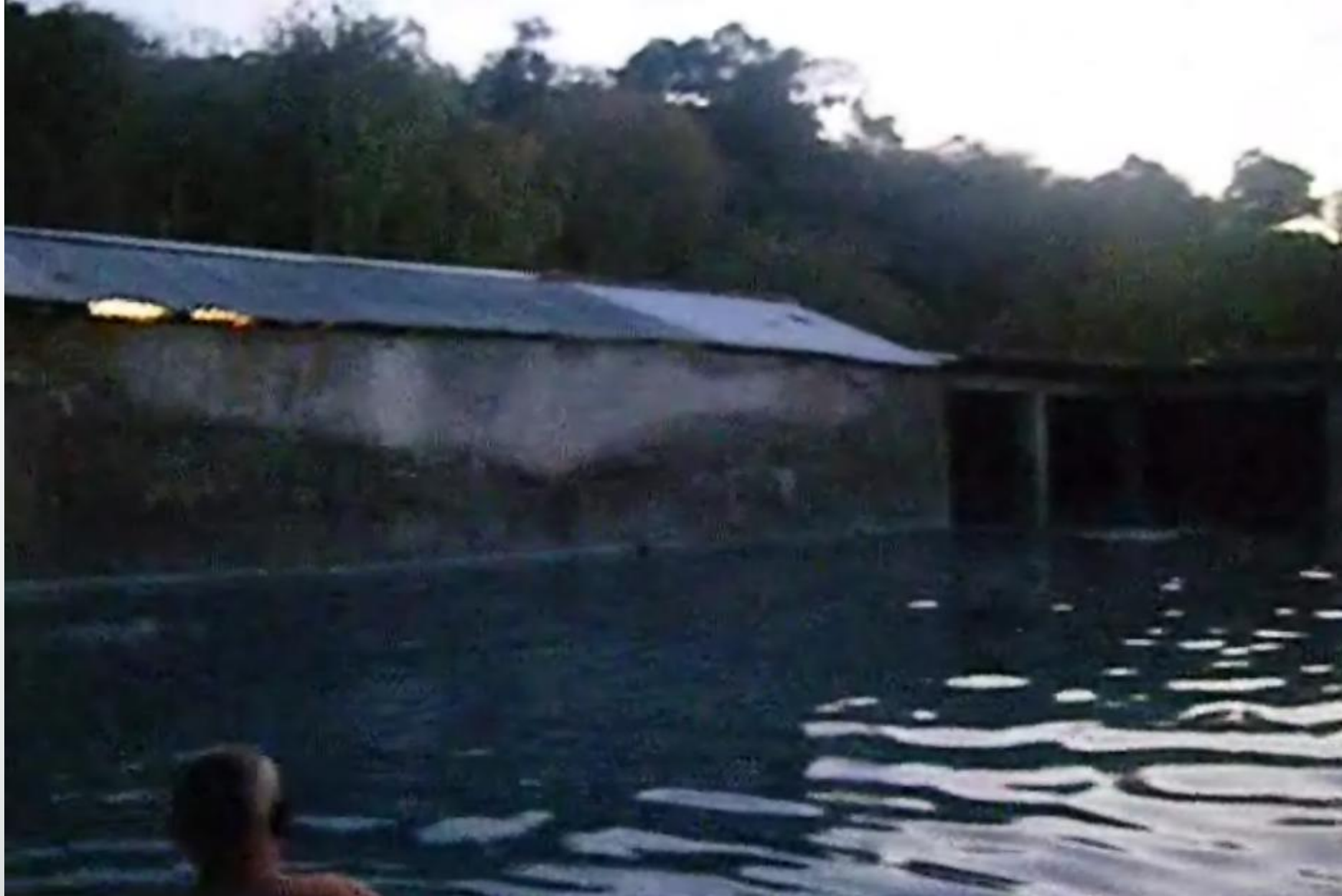
Balneario de agua termal en "Los Baños".
